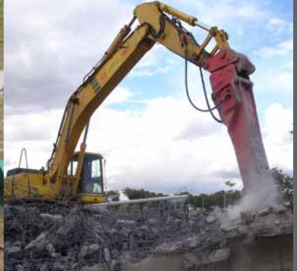
Ejecución material de todo tipo de demoliciones mecánicas, mediante maquinaria propia específica de demoliciones, brazos de largo alcance, demoledores hidráulicos, cizallas hidráulicas y martillos hidráulicos de gran tonelaje.
