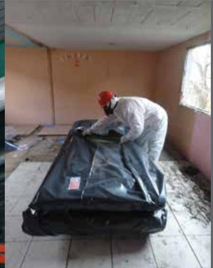
Se realizan trabajos de retiro y desmantelamiento de materiales con contenido en asbesto, no friables como asbestocementos (comúnmente conocidos como “pizarreños”), y friables como aislantes de calderas, asbestos proyectados, etc..
