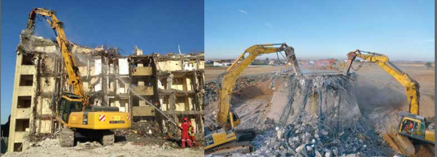
Demoliciones en altura con total seguridad, rapidez y adecuada separación de los materiales en origen con objeto de maximizar las recuperaciones y minimizar los volúmenes de escombros a transportar a depósito.
