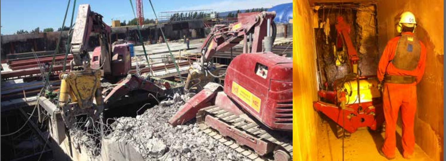
Demoliciones con robots dirigidos por control remoto equipados con pinzas de demolición y martillos hidráulicos.
